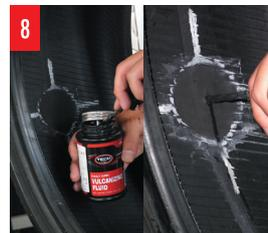
8 760ケミカルセメントを915スパイラルツールにたどりつけてタイヤの内側・外側からそれぞれ右回転にて傷穴に入れます。3〜5回程度繰り返して最後に外側から挿したままにしてセメントの乾燥・傷穴の収縮を防ぎます。\*249ULは910セメントツールを使用
